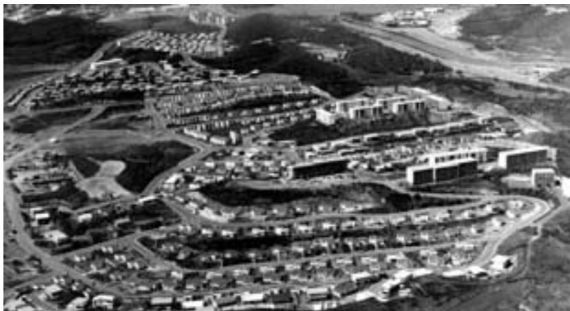
1968 -1980 construction de Rivière Salée
