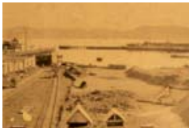
1898 encaissement des quais
