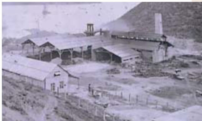
Usine de la Pointe Chaleix
